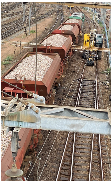
Chantier de remplacement du ballast. Des milliers de km de lignes de chemin de fer ont été laissés sans entretien suffisant depuis un demi-siècle...
